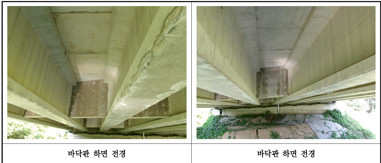
【사진 8.3.2】 바닥판하면 전경
