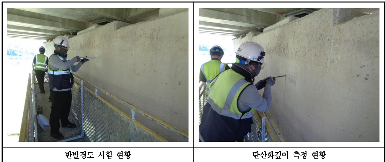
【사진 8.4.1】 콘크리트 내구성조사 현황
