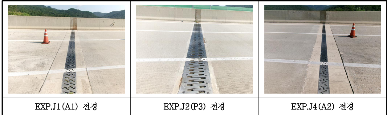
【사진 8.3.16】 신축이음장치 전경
