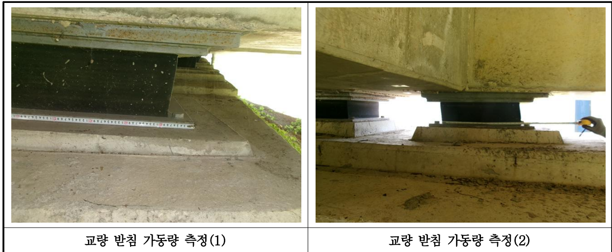
【사진 8.3.15】 교량받침 이동량 측정
