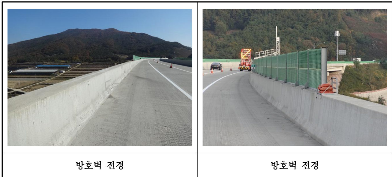
【사진 8.3.23】 방호벽 및 중앙분리대 전경
