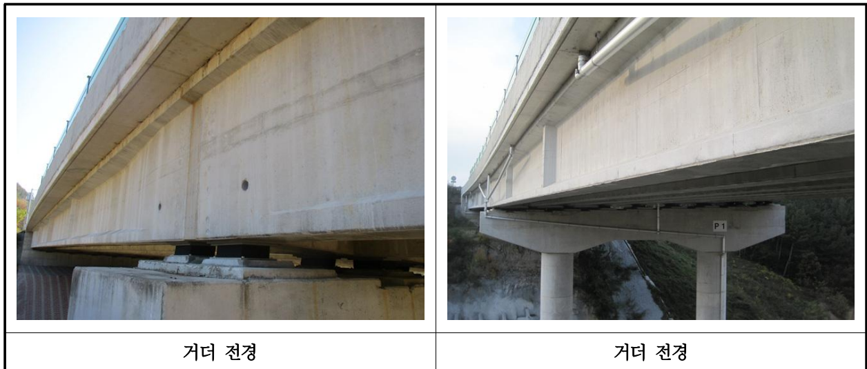
【사진 8.3.4】 거더 전경
