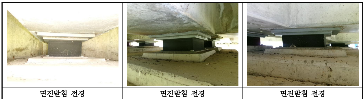
【사진 8.3.12】 교량받침 전경
