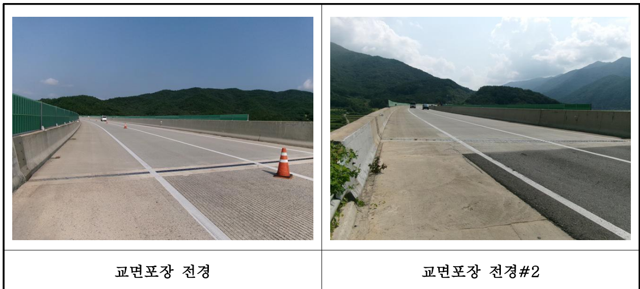
【사진 8.3.19】 교면포장 전경
