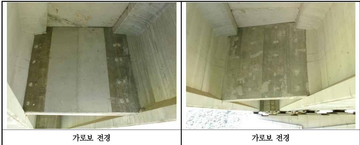
【사진 8.3.6】 가로보 전경
